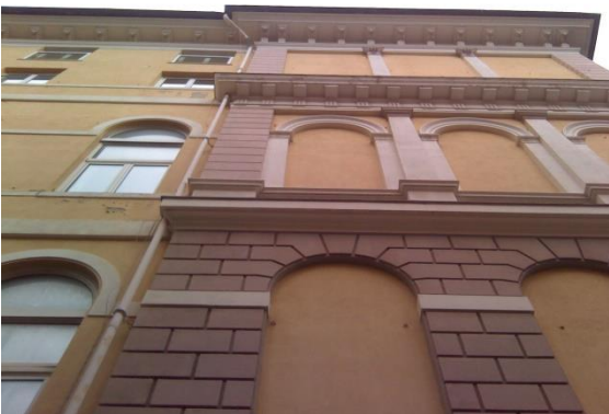
Figura 5: Particolare facciata aperture tamponate
