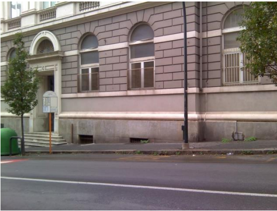
Figura 1: Prospetto principale est ingresso
